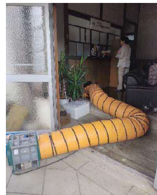
送風機による床下の乾燥
