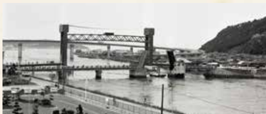
▲天草瀬戸大橋と瀬戸歩道橋
