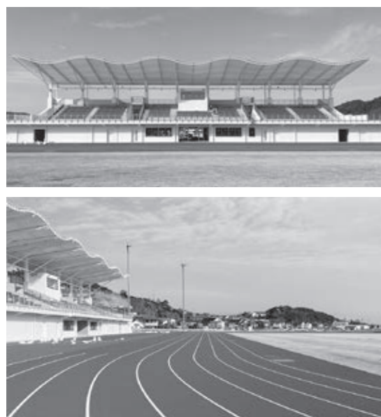
▲建設中の新陸上競技場
