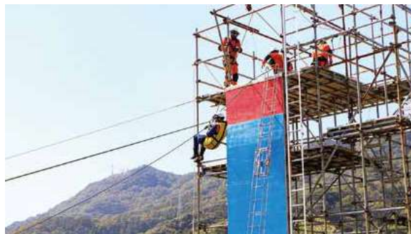
▲高い建物からの救出を想定した訓練
