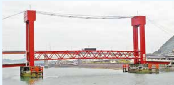
▲②瀬戸歩道橋（本渡）※風速15m/sで通行止め
