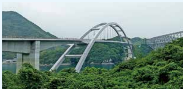
▲③天城橋（三角大矢野道路）※風速15m/sで通行止め
