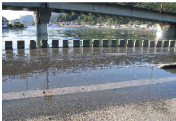
整備前（高潮による冠水時）
