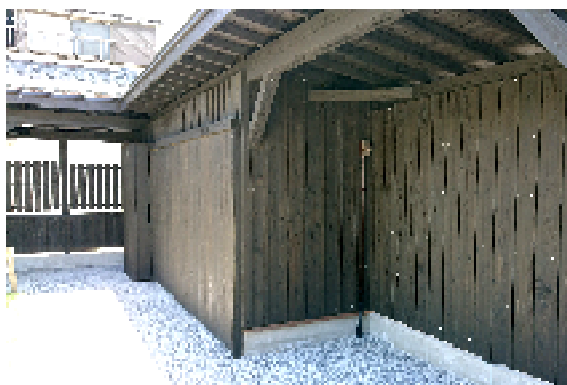
木塀・屋根と一体型の収納庫
