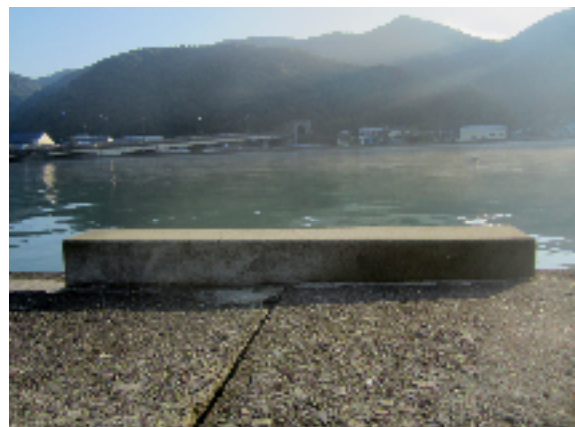
整備された車止め
