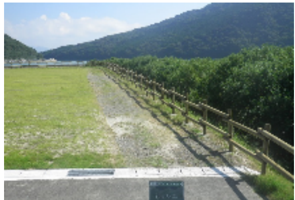
木製の転落防止柵
