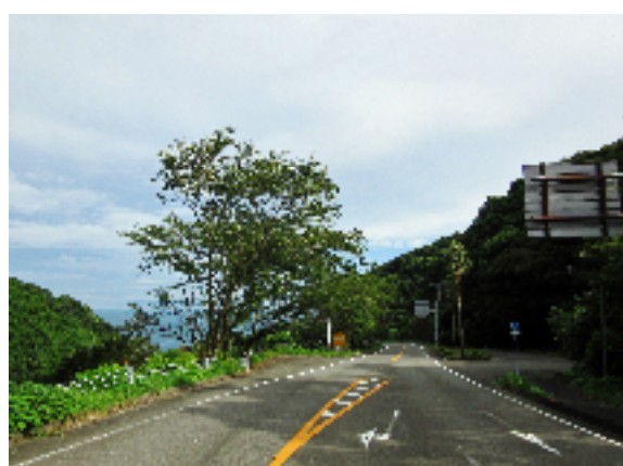
天草西海岸[国道 389 号沿線] 除伐後
