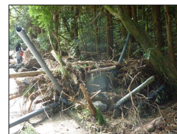
島子浄水場 導水管流出状況
