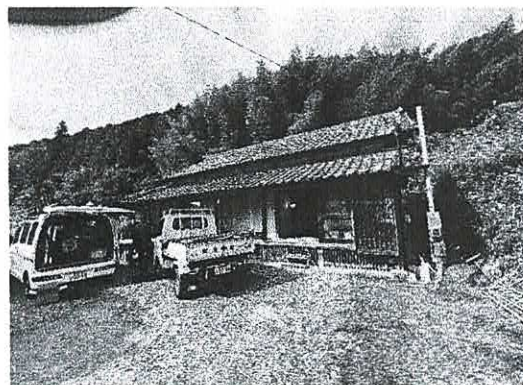
現在改修中の中間管理住宅
