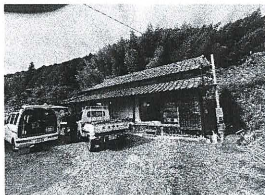
現在改修中の中間管理住宅
