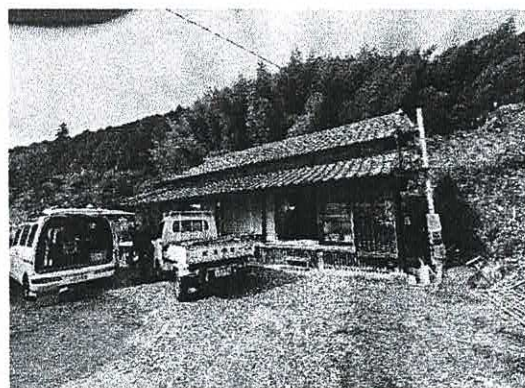
現在改修中の中間管理住宅
