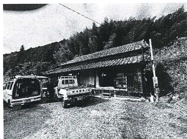
現在改修中の中間管理住宅
