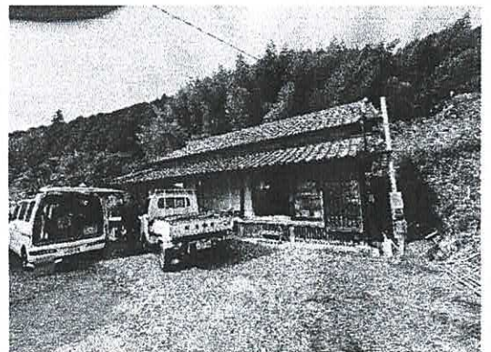
現在改修中の中間管理住宅
