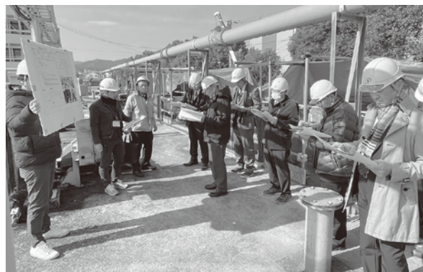
▲本渡浄化センターの現地調査
