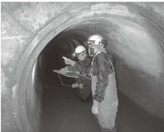
▲管内点検を実施する作業員
