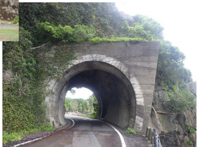
番所隧道（1958 年竣工）
