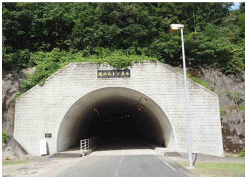
樅の木トンネル（2003 年竣工）
