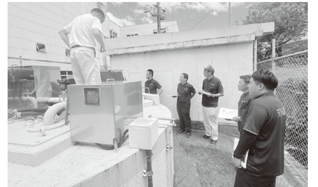
▲水俣水源池の現地調査
