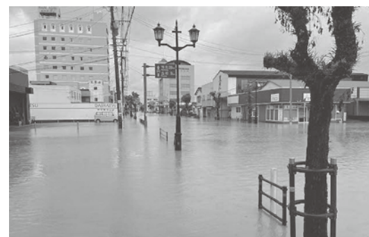
▲令和7年8月豪雨直後の国道324号線（太田町）
