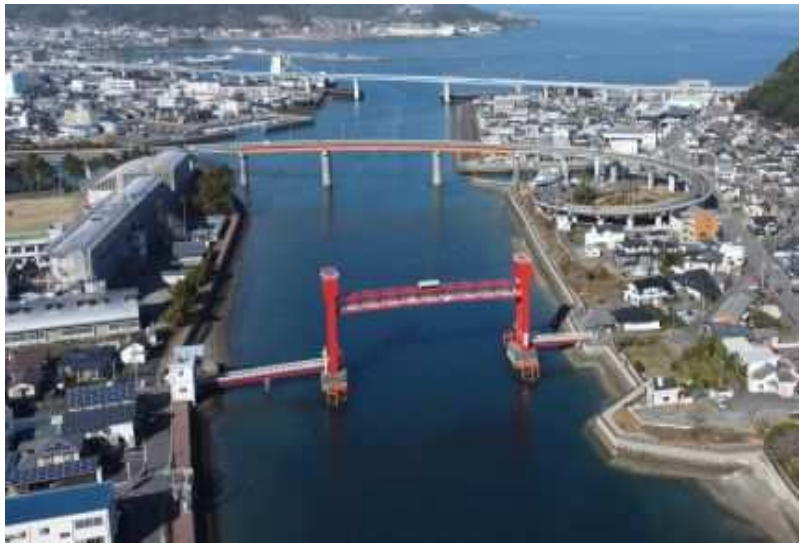
(上島下島を結ぶ天草未来大橋、瀬戸大橋、瀬戸歩道橋)
