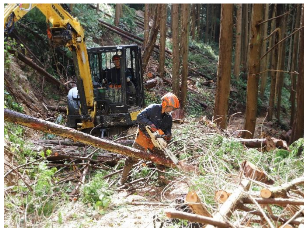
間伐を行っている様子
