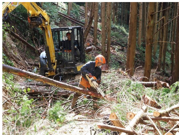
間伐を行っている様子
