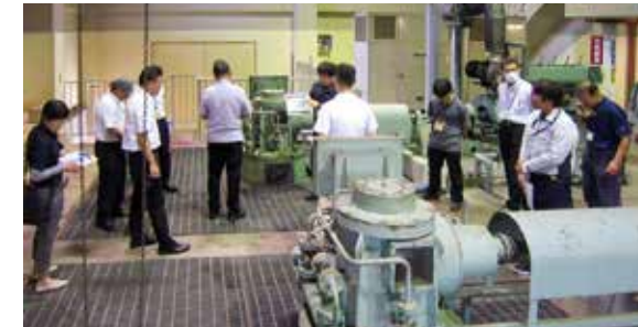
▲浄南雨水ポンプ場の現地調査
