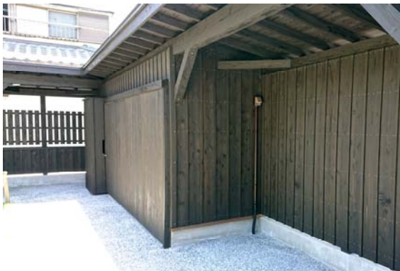
木塀・屋根と一体型の収納庫
