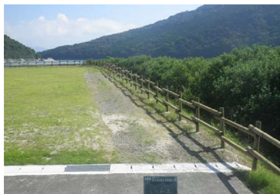
木製の転落防止柵
