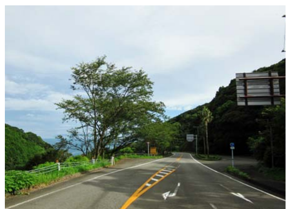
天草西海岸〔国道 389 号沿線〕除伐後
