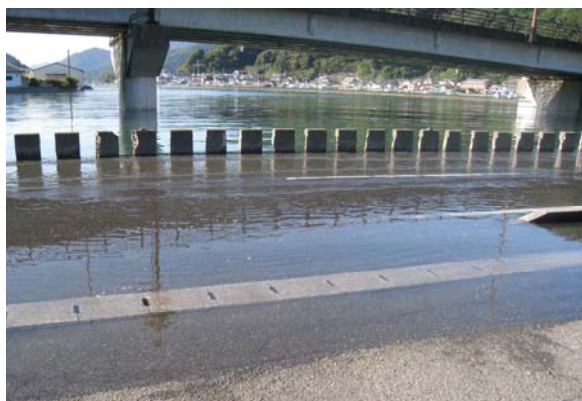
整備前（高潮による冠水時）
