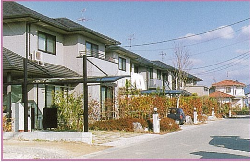
● 八代市・グランドールの街 車庫は透視性のあるものとし、門柱と照明を統一して連続性を生み出している。
