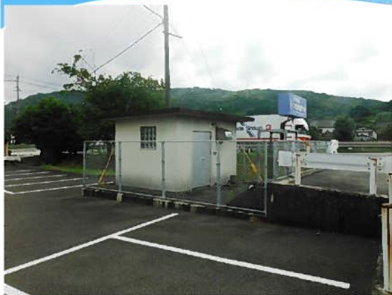
亀川污水中継ポンプ場
