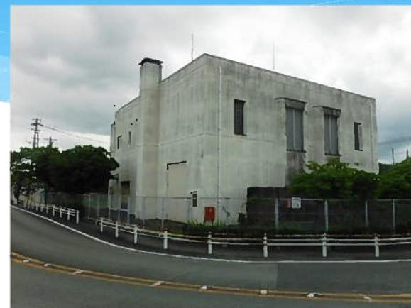
浄南雨水ポンプ場
