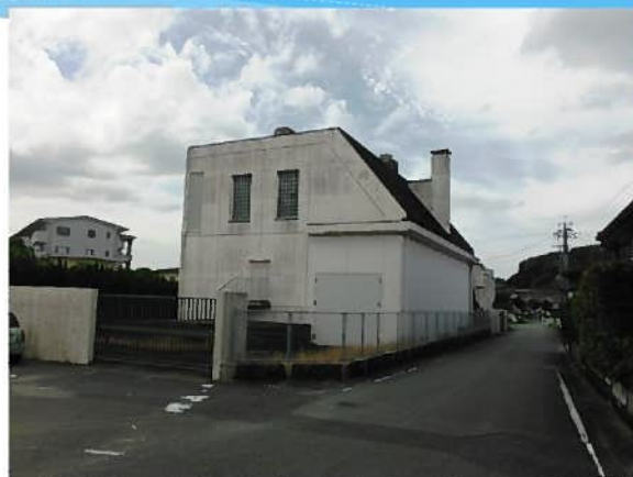
広瀬雨水ポンプ場
