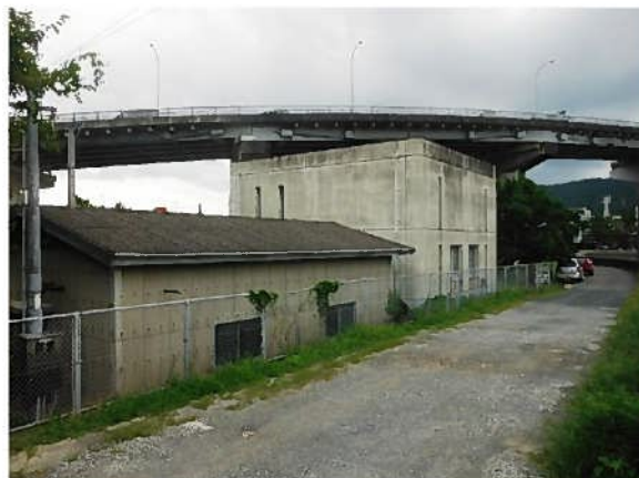
瀬戸雨水ポンプ場
