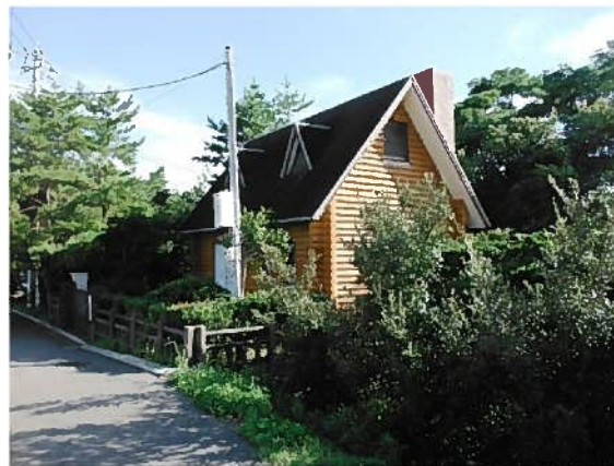
茂木根污水中継ポンプ場
