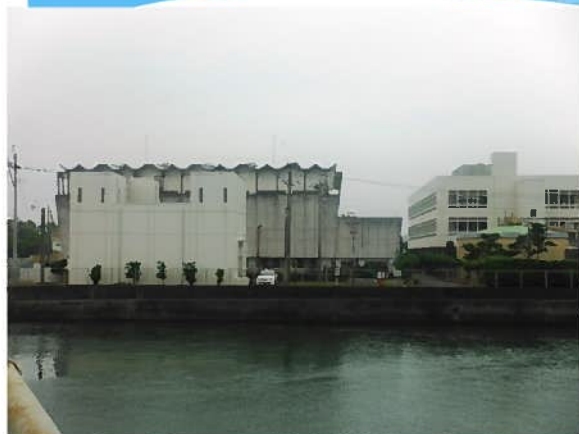
今釜新町ポンプ場
