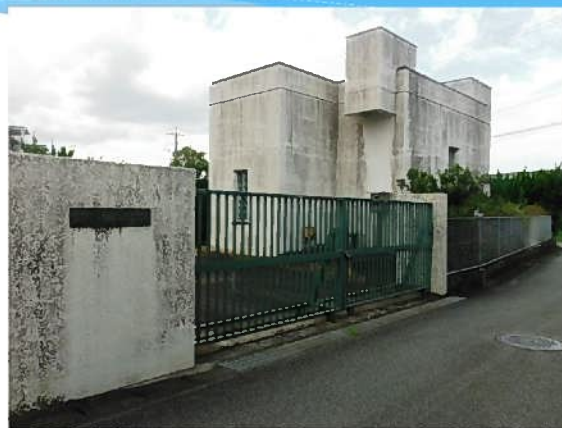
広瀬污水中継ポンプ場
