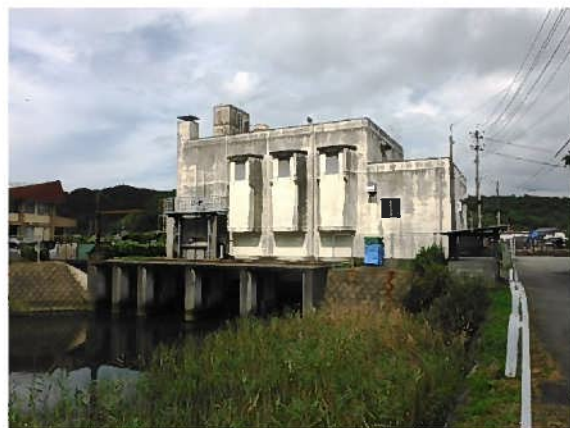
浜田雨水ポンプ場
