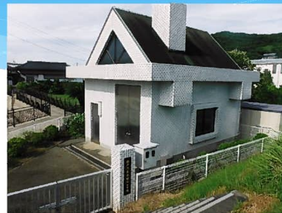
瀬戸污水中継ポンプ場
