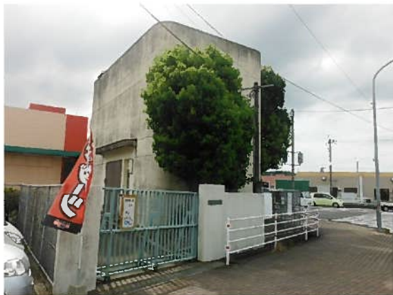
浜田污水中継ポンプ場
