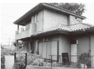
空き家の状況
