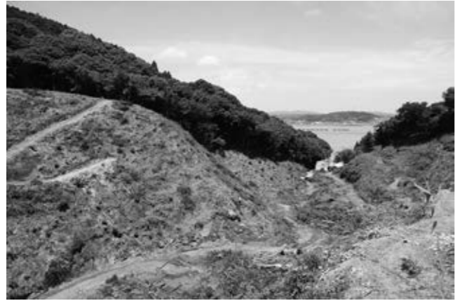
▲造成工事が進む 瀬戸地区の建設予定用地
