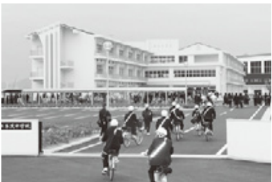
▲本渡中学校を建設
