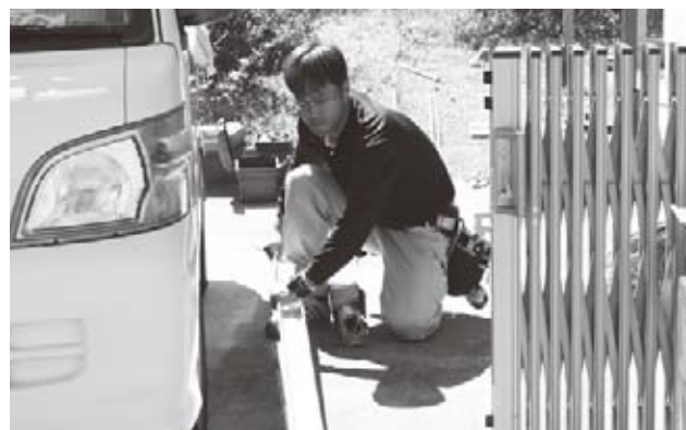
▲配線工事を行う岸谷さん
