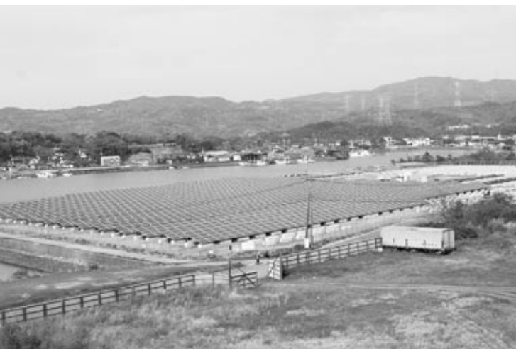
◀工事が進む市有地を活用したメガソーラー発電所（楠浦町）
