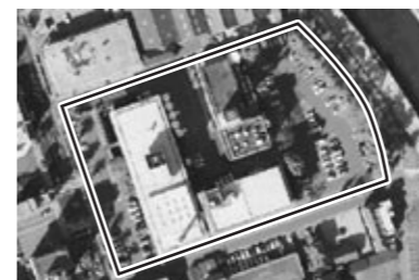
◀空から見た本庁舎敷地
