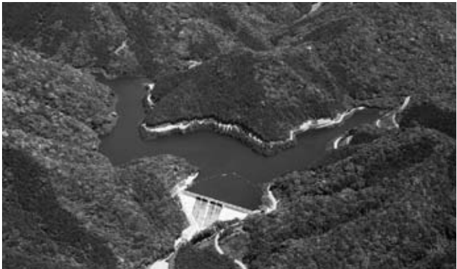
▲4月1日に給水が始まった県営路木ダム（河浦町）
