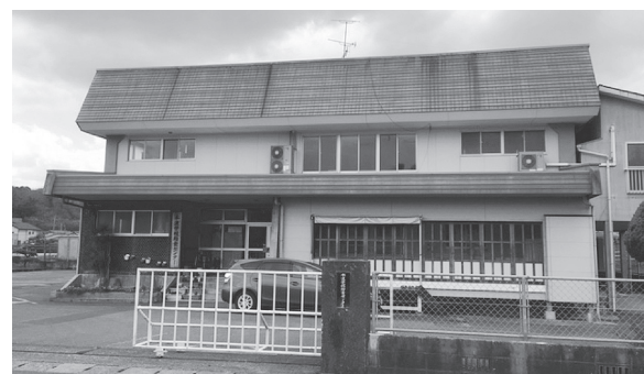
建築後40年を超え建物、設備共に老朽化が激しい「本渡学校給食センター」。 天草市全体の給食供給数7,391食中4,000食以上を賄う施設だけに1日も早い建設が望まれる。
