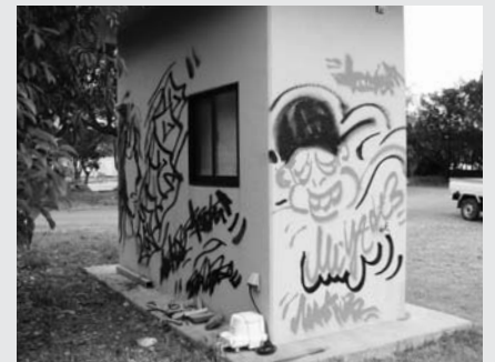
▲柵本稚児崎海浜公園内のトイレの落書き
