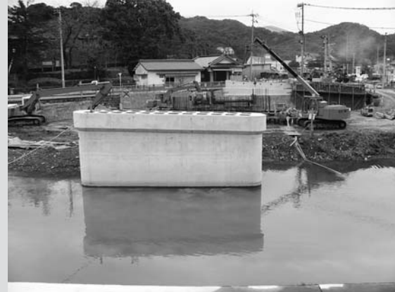
橋の架替工事
