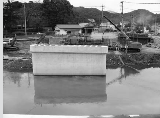
橋の架替工事
