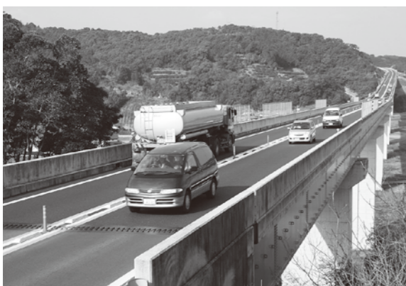
▲昨年9月に開通した熊本天草幹線道路「松島有明道路」
