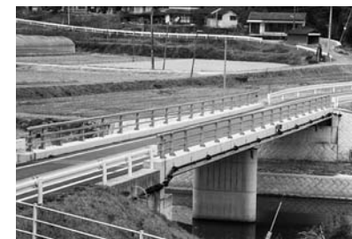
▲浪床橋(新和町大宮地)が完成
