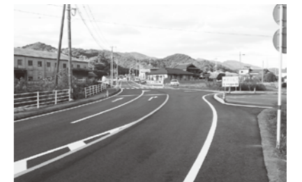
▲河浦町・一町田中央線道路改良工事
