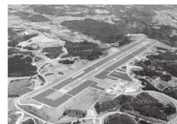
▲天草空港の全景
