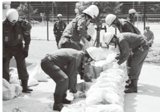
▲「改良積み土のう工法」を実施する消防団員
