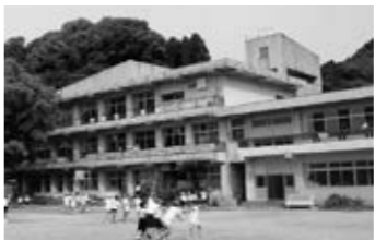
旧校舎(昭和59年完成)
