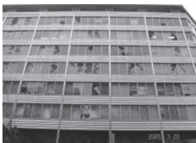
地震時の層間変形による破損 (東京大学/清家剛准教授提供)
