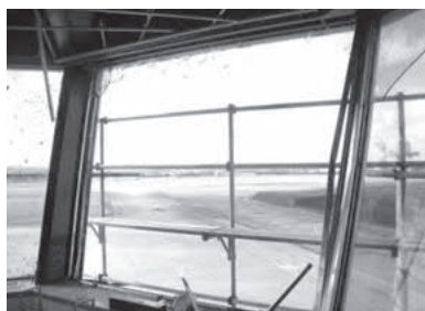
宮古空港管制塔 (建築研究所提供)
