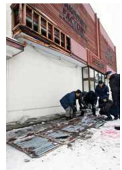
落下した外壁
