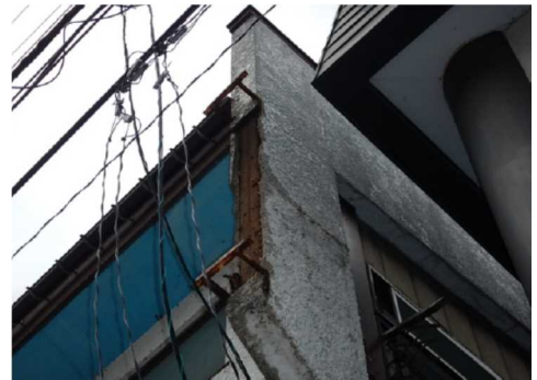
外壁剥離箇所
