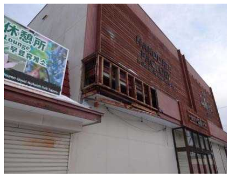
外壁落下後の建物写真②
