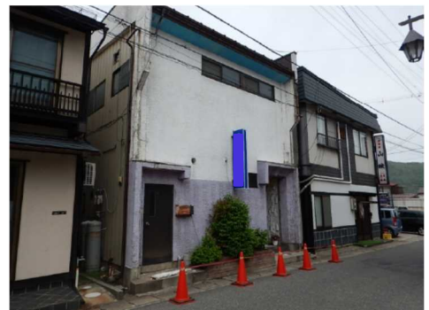
外壁落下建物全景
