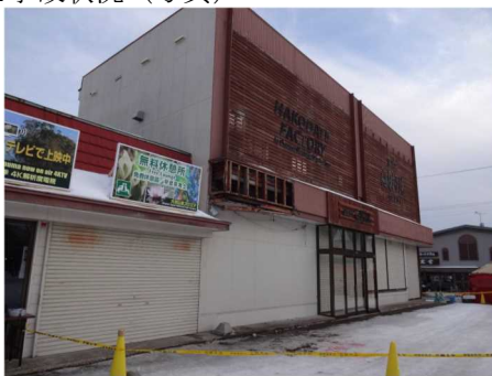
外壁落下後の建物写真①
