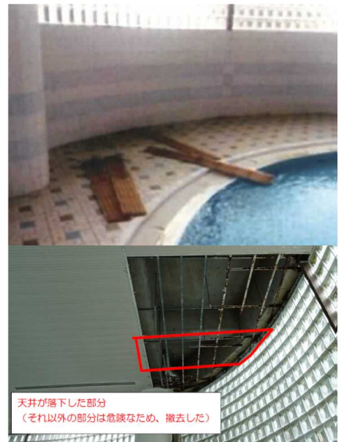
■事故状況 (写真)
