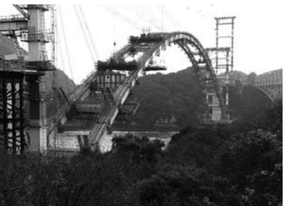
▲新天門橋(新1号橋)建設のようす
