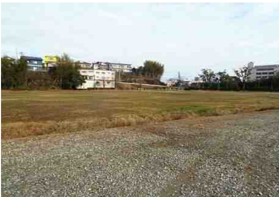
③計画地内より北東方向を望む
