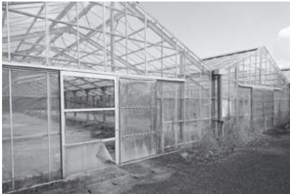
▲払い下げを行う温室ハウス
