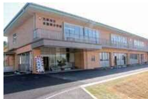
▲本渡東小学校の新校舎
