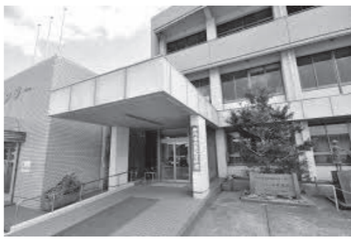
現在の資料館が入る御所浦地区コミュニティセンター
