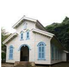
⑪ 奈留島の江上集落 (江上天主堂とその周辺) 江上天主堂
