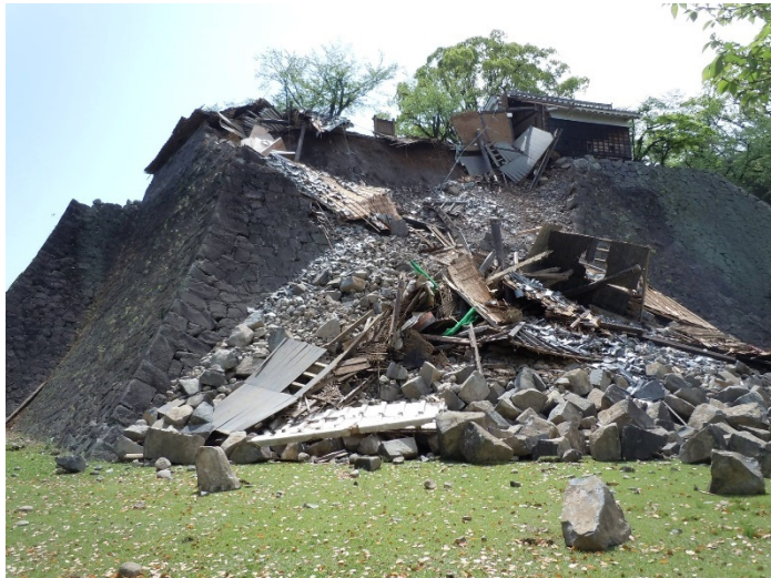
図 平成28年熊本地震による被害 熊本城、被災後の北十八間櫓（中央）と東十八間櫓（左奥） 国指定重要文化財
